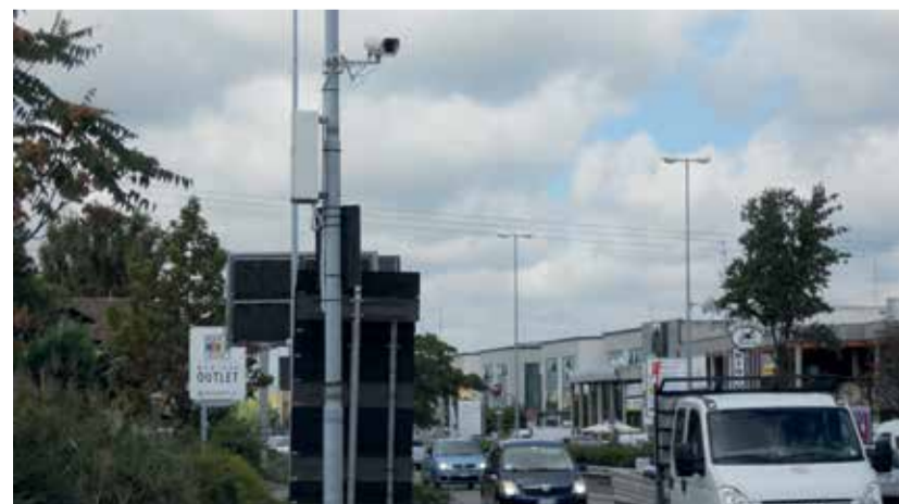
Via Emilia, impianto di videosorveglianza
