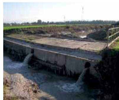
Sistemazione del Tresinaro (foto d'archivio)
