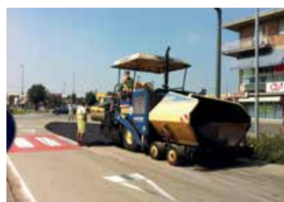
Asfaltatura della S.S.9 (foto d'archivio)
