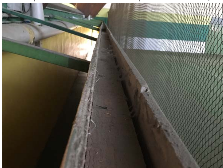
Percorso di collegamento tra i due campi coperti
