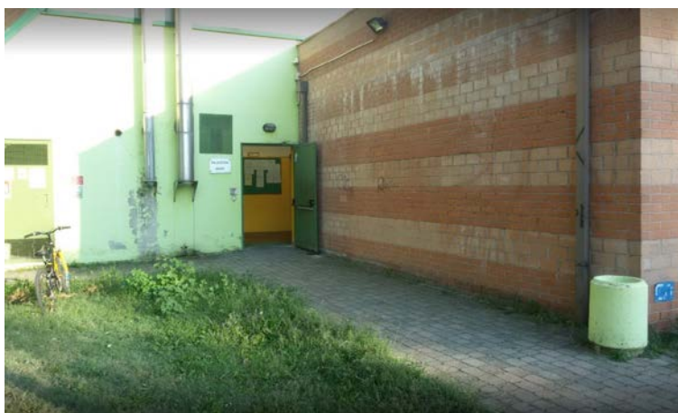
Ingresso atleti – adiacente corpo spogliatoi
