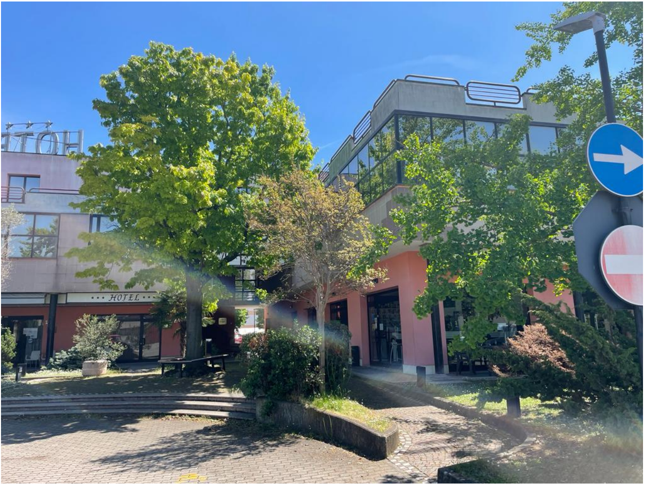
Vista 7 Stato di fatto: prospetto ovest, veduta della galleria
