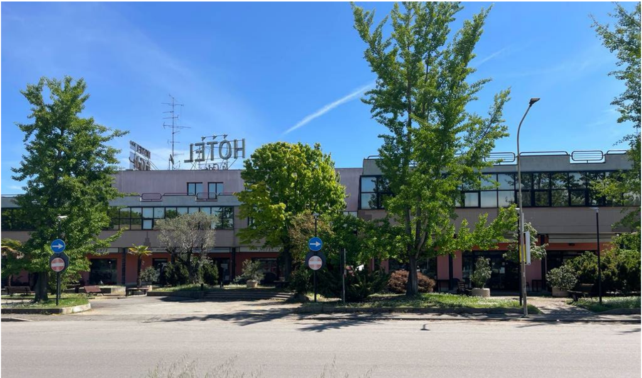
Vista 6 Stato di fatto: prospetto ovest dello stabilimento, con vista degli accessi principali.
