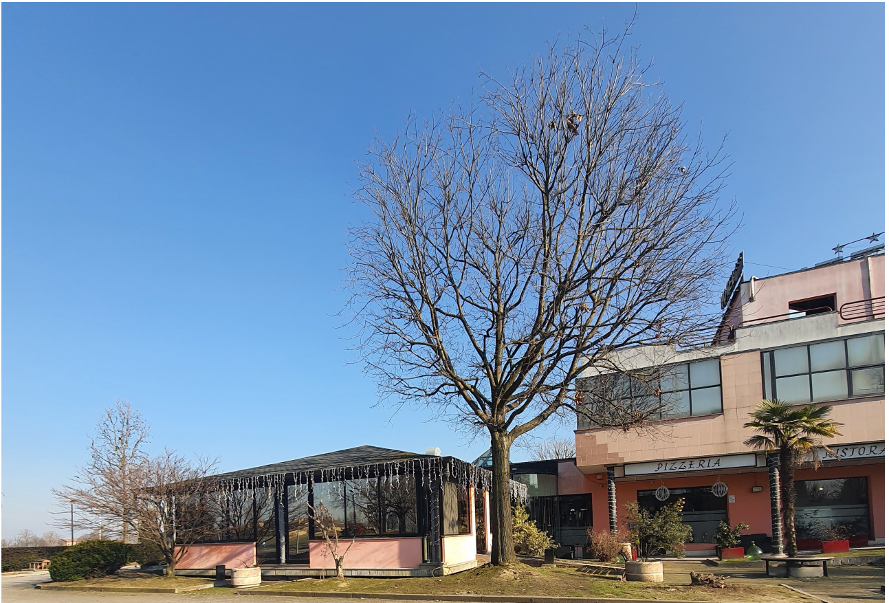
Vista 11: prospetto ovest particolare ingresso ristorante.
