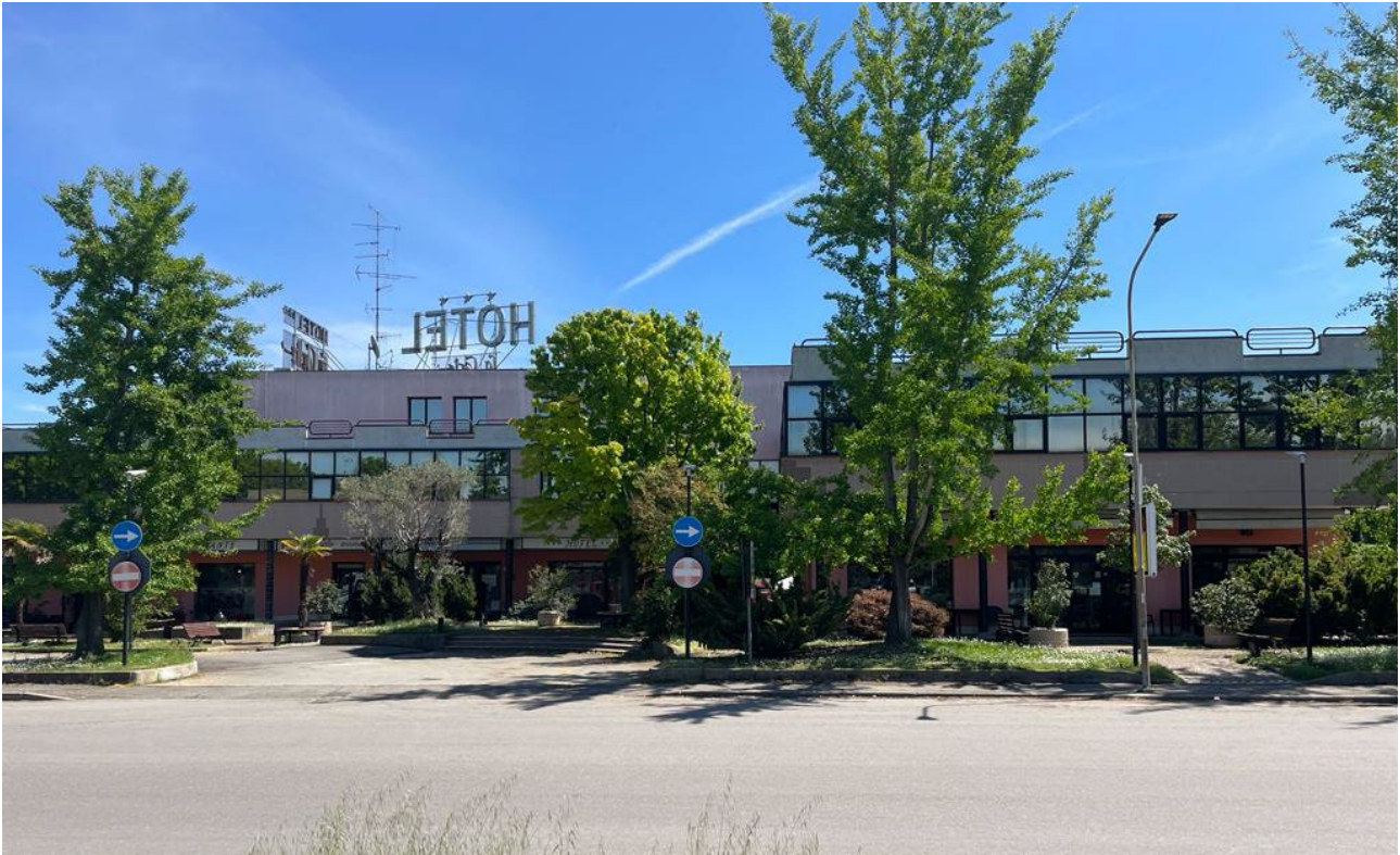
Vista 15: prospetto ovest.
