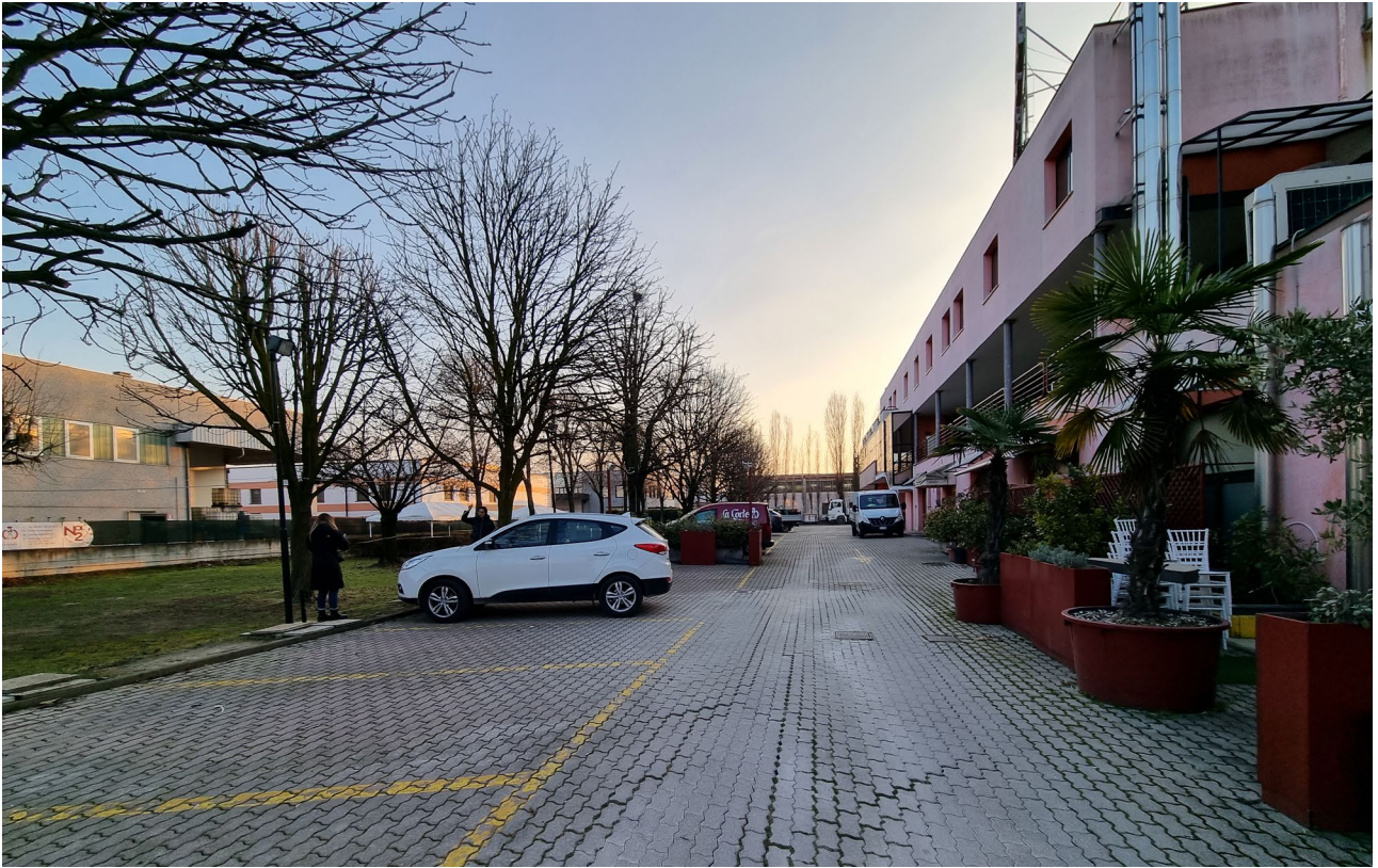
Vista 5: prospetto est, ripresa dall'area cortiliva con particolare del piano primo.
