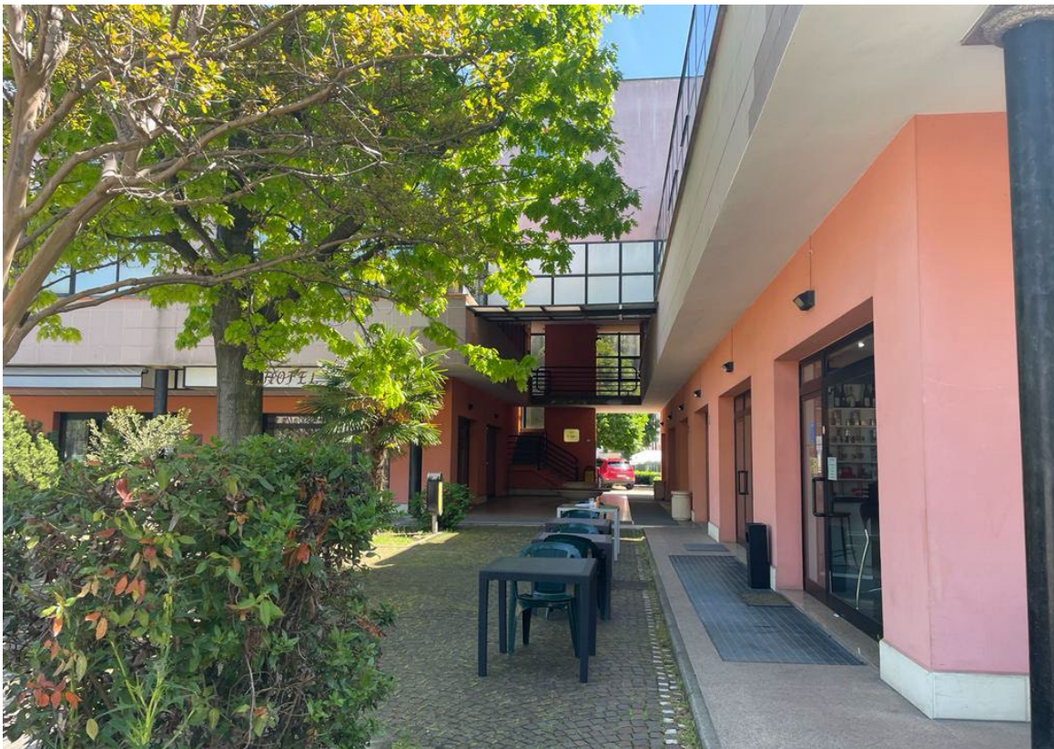
Vista 14: prospetto ovest, particolare ingresso dell'hotel.
