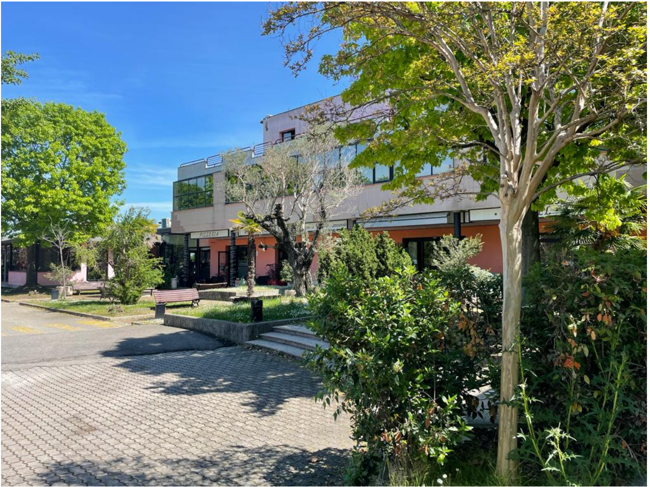
Vista 8 Stato di fatto: prospetto ovest con ripresa della parte cortiliva antistante il ristorante.
