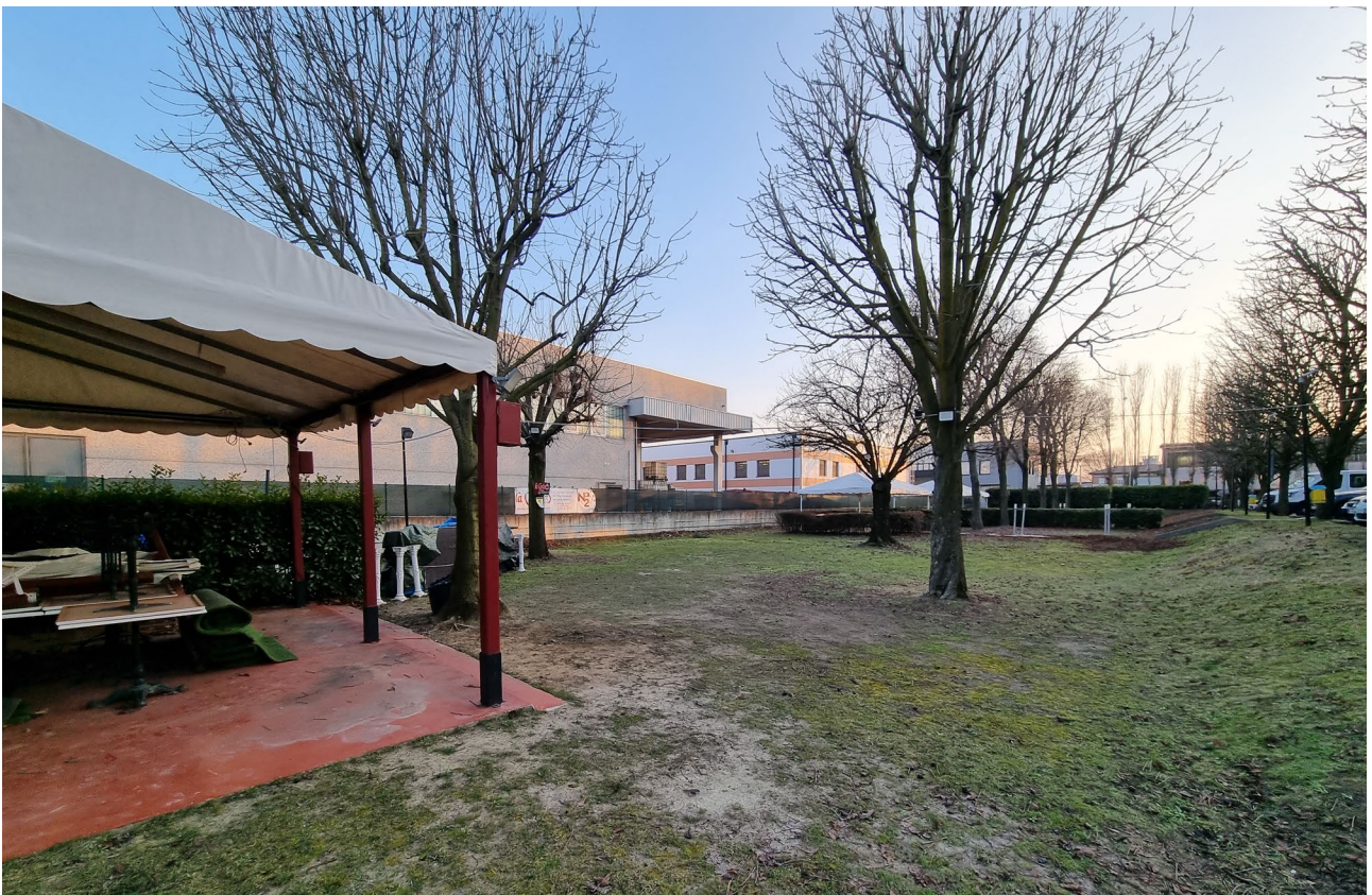
Vista 6: prospetto est ripreso dal cortile.
