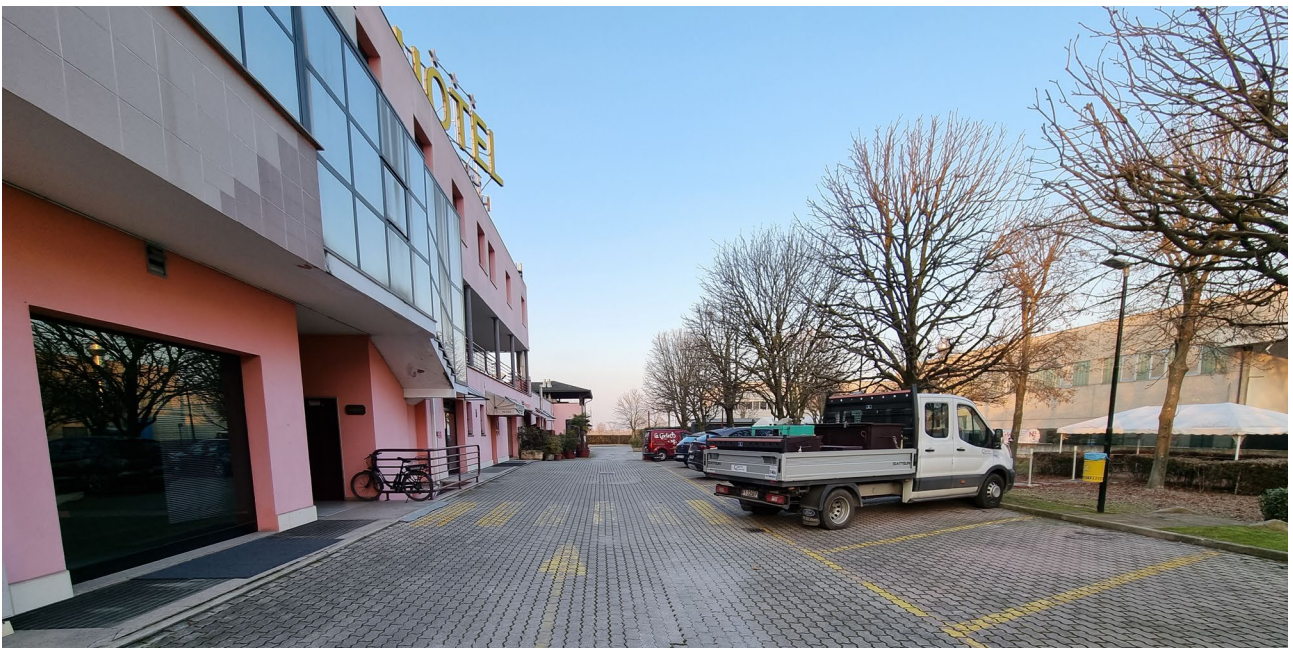
Vista 2: particolare del prospetto est fronte giardino.
