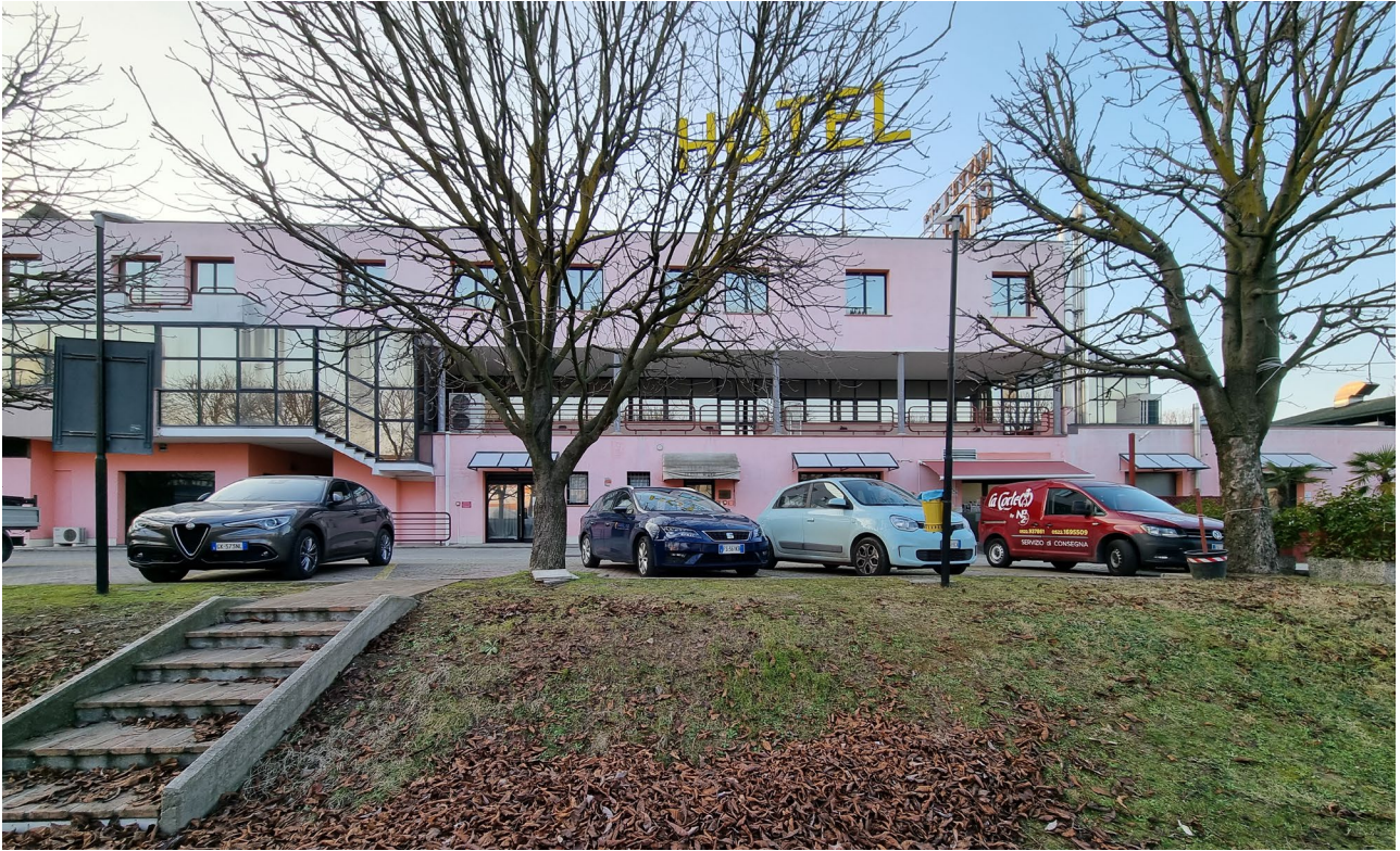
Vista 3: prospetto est, ripresa dall'area cortiliva con particolare del piano primo.
