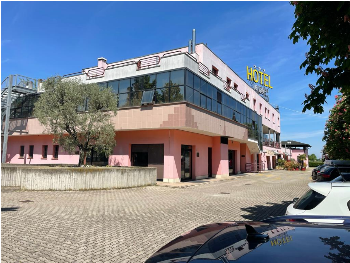
Vista 2 Stato di fatto: prospetto sud-est.
