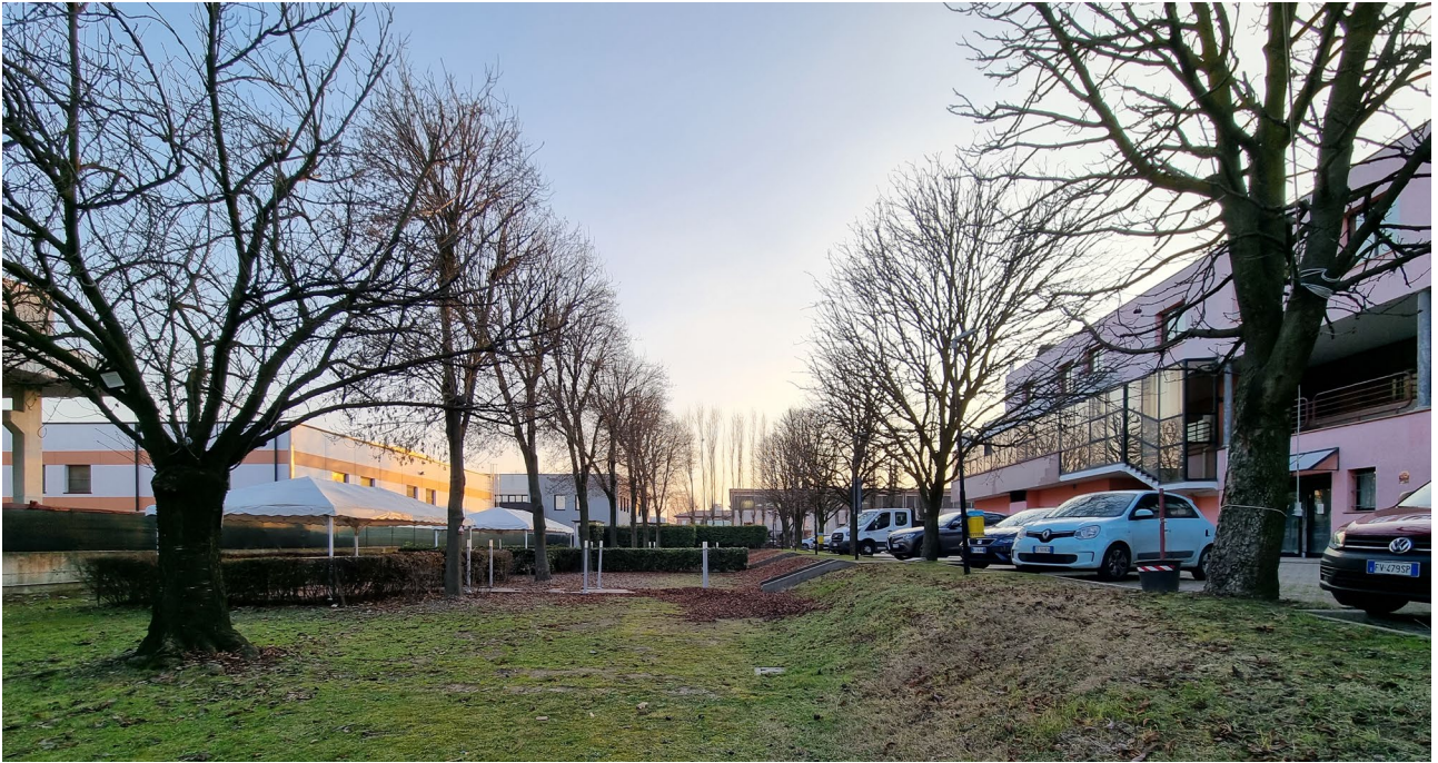
Vista 7: prospetto est ripreso dal cortile.
