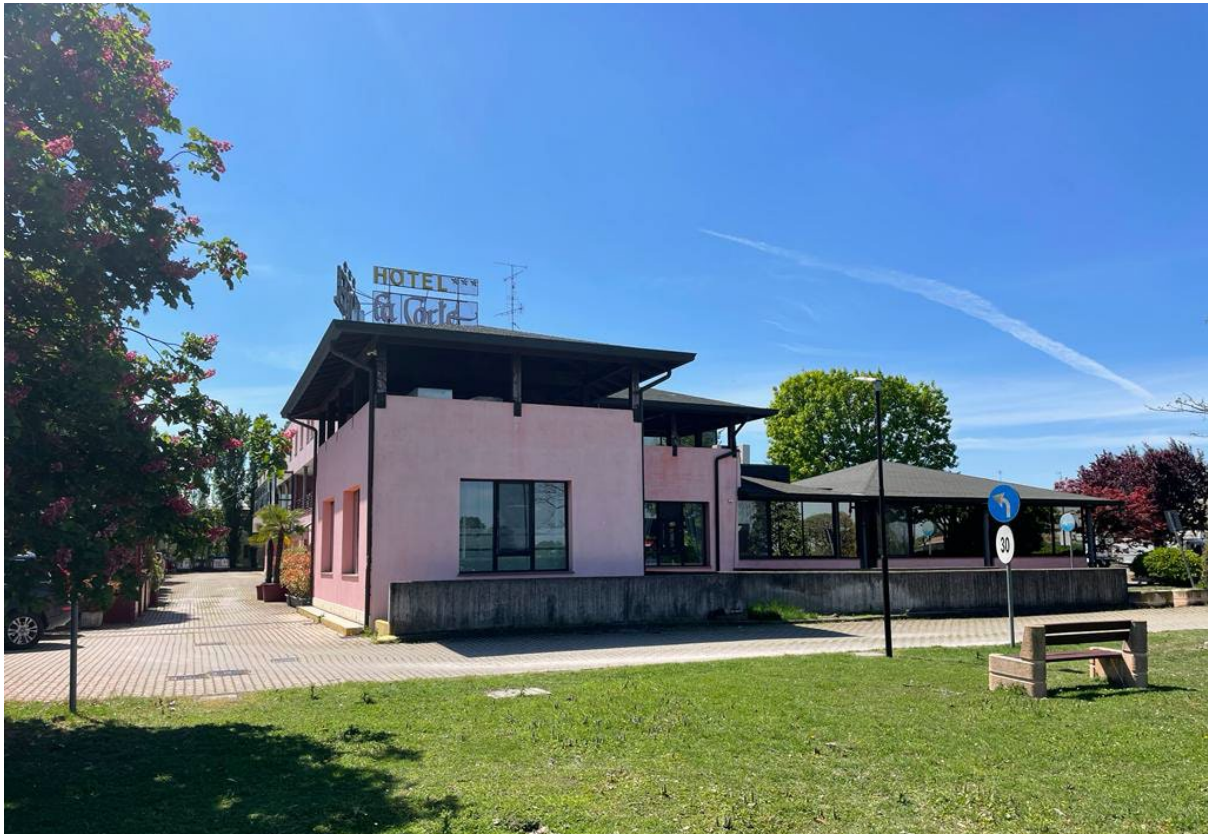
Vista 9: prospetto sud.
