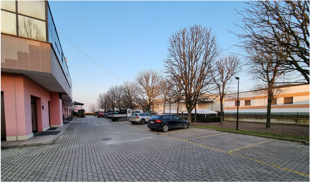
Vista 3 stato di fatto: prospetto est veduta del cortile.
