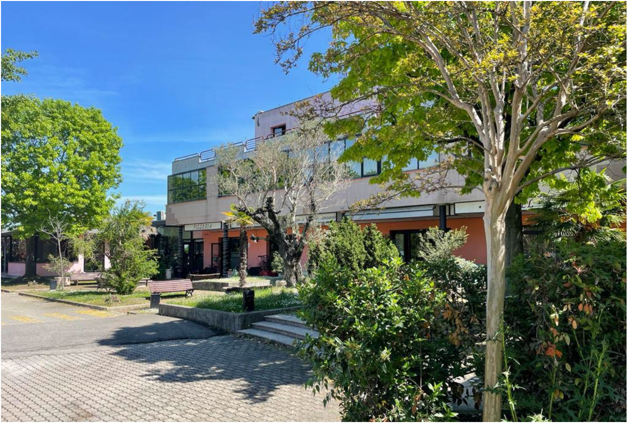
Vista 13: prospetto ovest, particolare ingresso dell'hotel.
