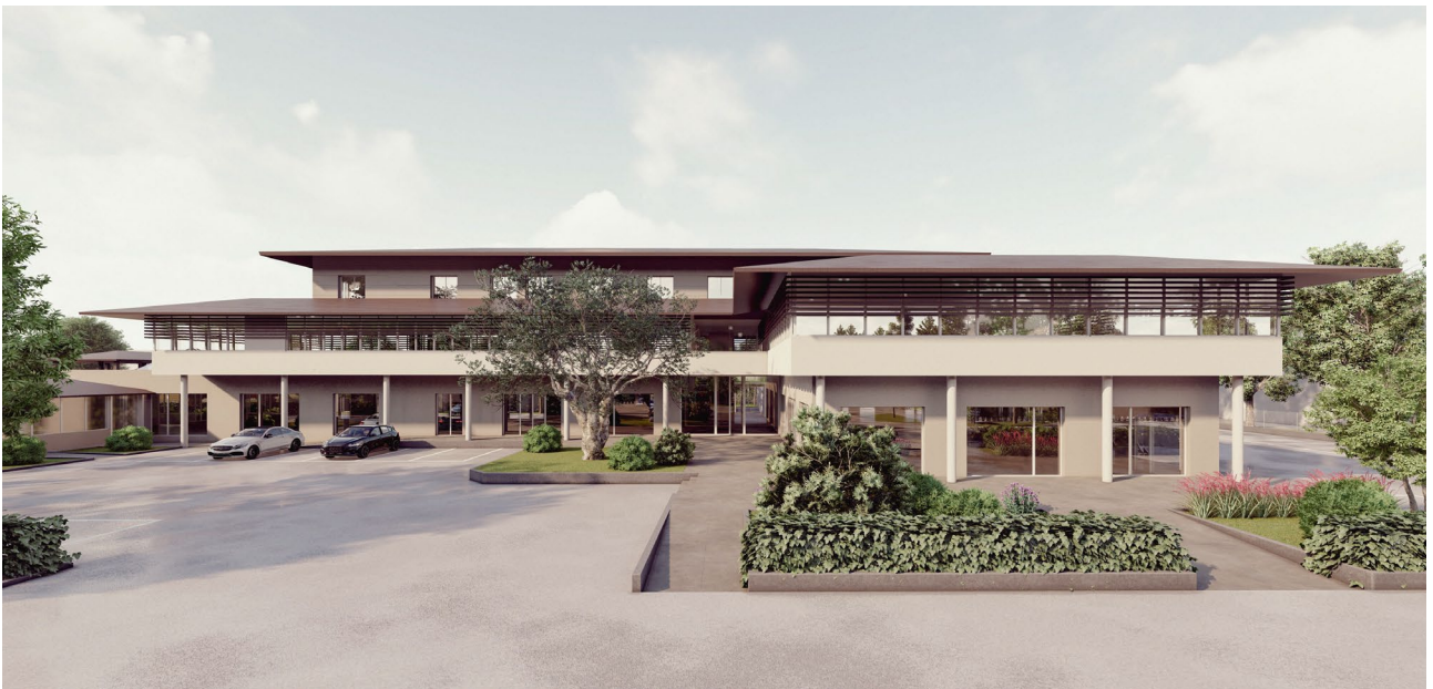
Vista 8: prospetto ovest, veduta del fronte principale dove sono collocati gli ingressi principali.
