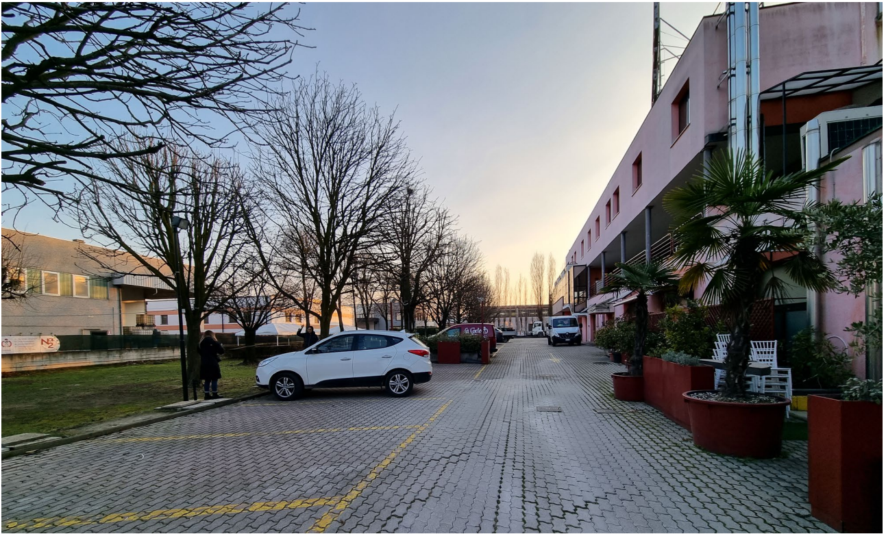
Vista 4: Stato di fatto: vista lato est, strada dietro l'edificio.
