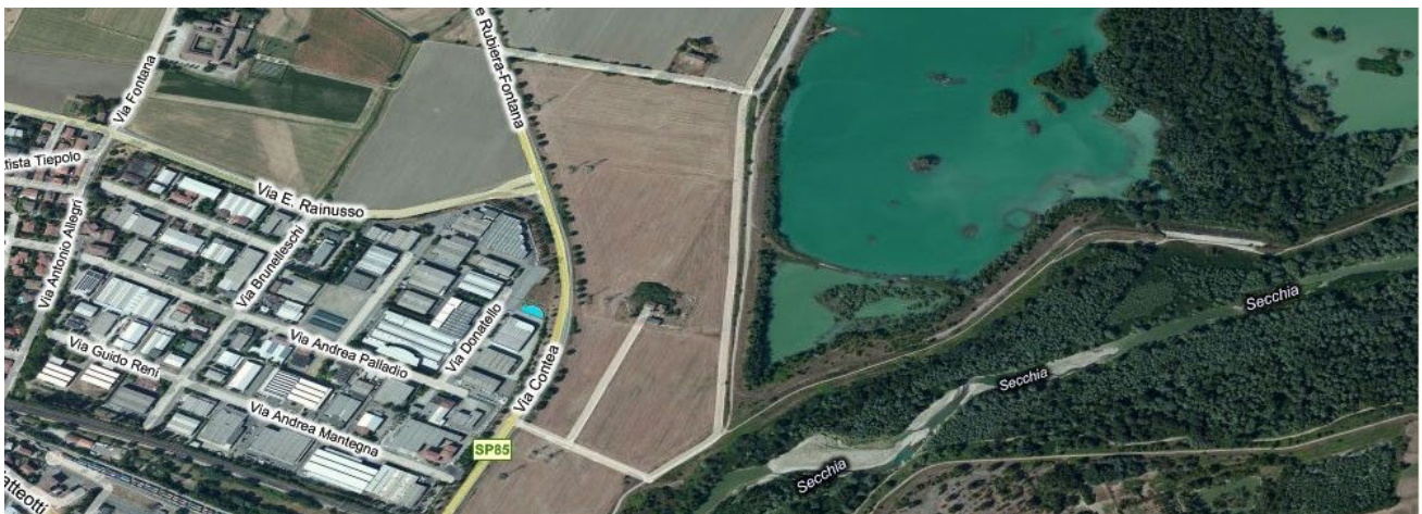
Ortofoto satellitare che mostra la vicinanza fra l'insediamento industriale del Villaggio artigiano (a sinistra) e l'ambito di tutela paesaggistico-ambientale relativo all'asta fluviale del fiume Secchia e le sue casse d'espansione (a destra)
