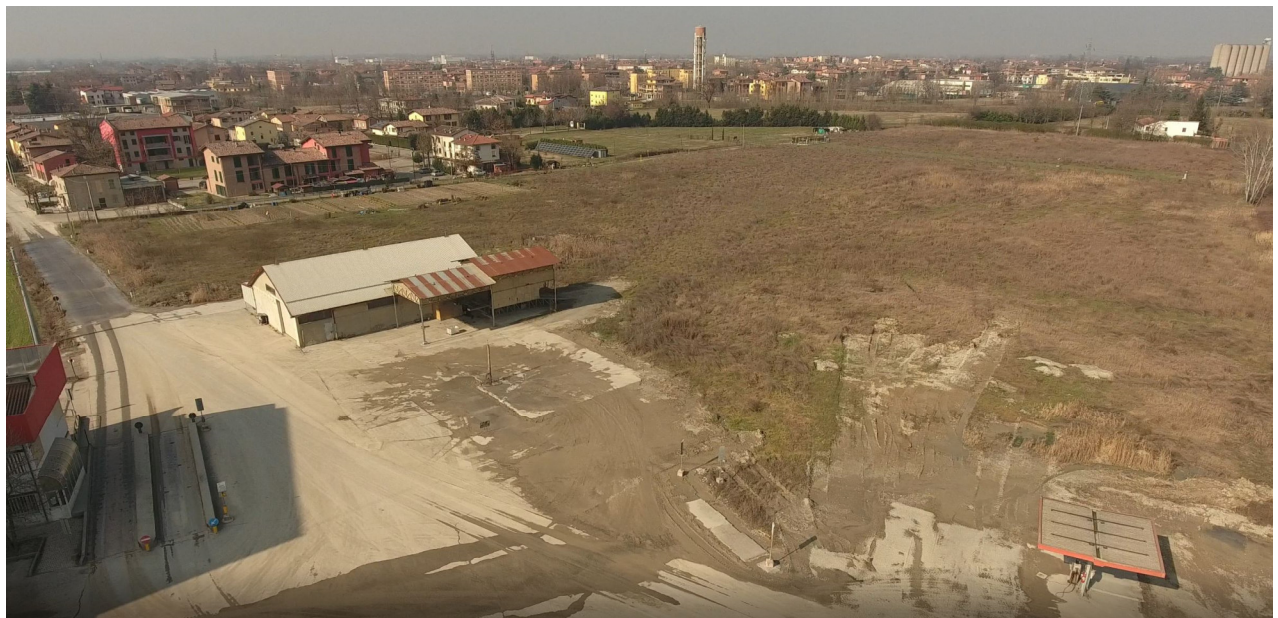
Figura 10 Area oggetto di intervento
