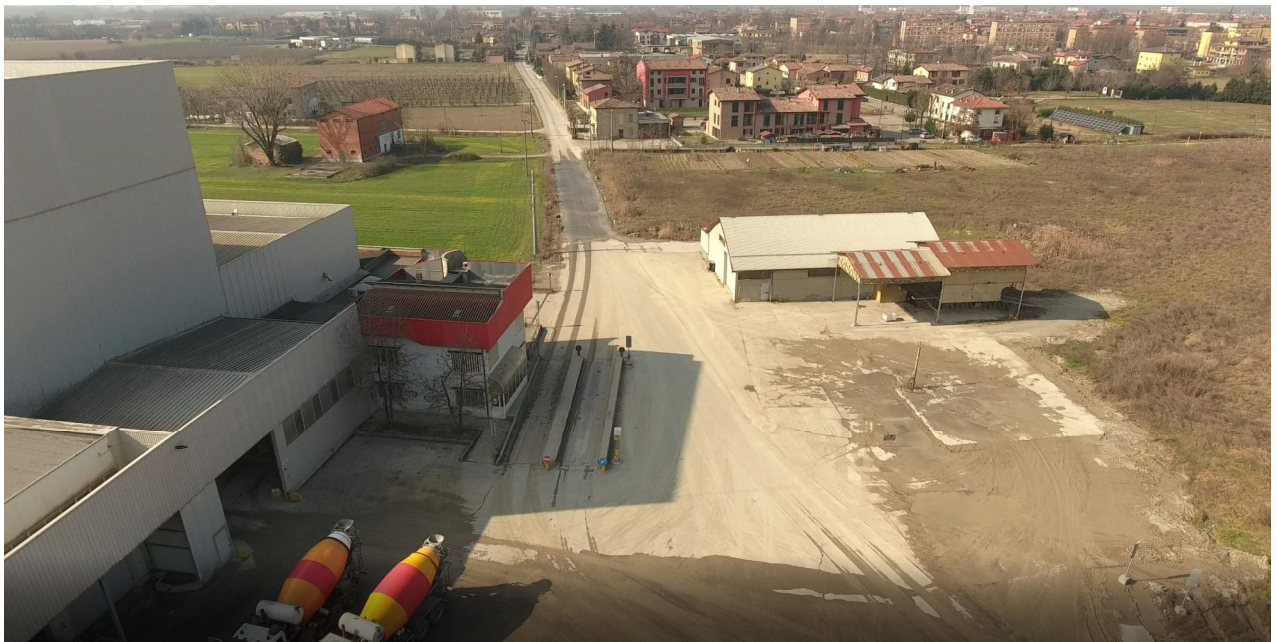
Figura 12 Area oggetto di intervento
