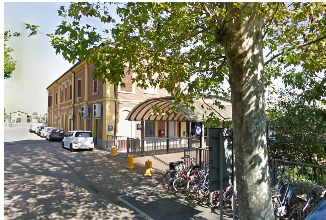
Figura 2-6 L'attuale configurazione della Stazione di Rubiera, in Viale della Stazione.
