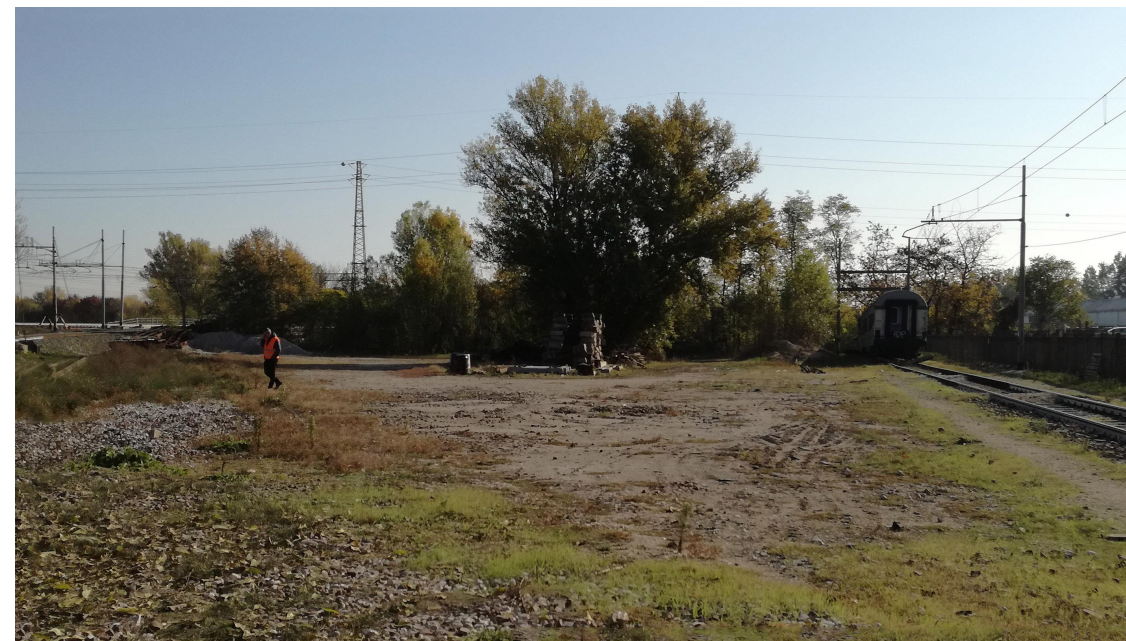
Figura 4-1 Piattaforma ferroviaria di Rubiera stato dei luoghi ante operam.
