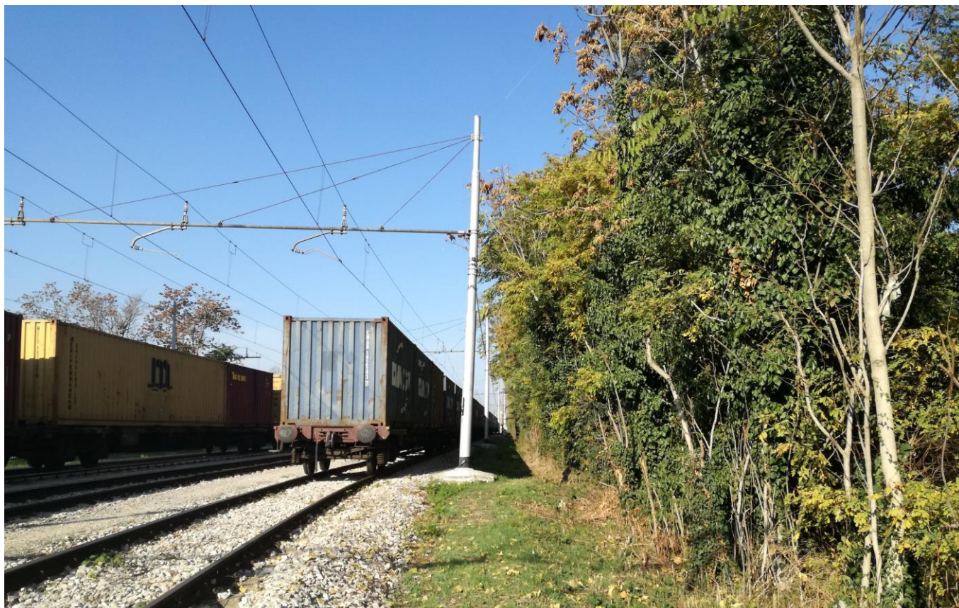
Figura 2-21 Fotografia realizzata durante il sopralluogo del 29 ottobre 2021. A destra dell'immagine la vegetazione invasiva-infestante costituita per lo più da ailanto.
