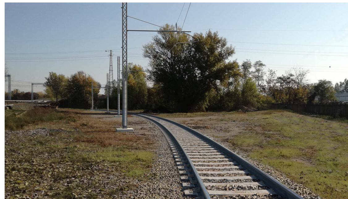
Figura 4-2 Piattaforma ferroviaria di Rubiera stato dei luoghi post operam
